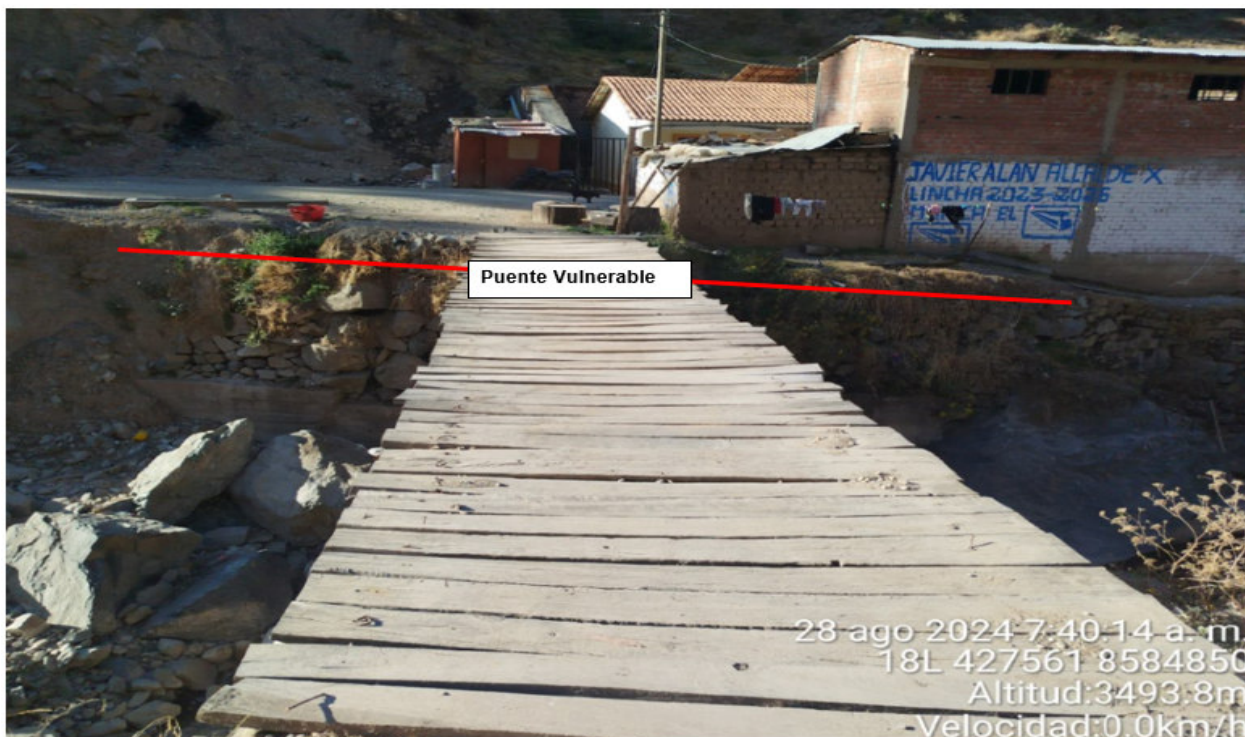
FIGURA N°02: SE OBSERVA LA MARGEN DERECHA DEL RIO EL CUAL ES VULNERABLE ANTE UNA CREDIDA, POR DICHO LADO ESTA LA BASE DE UN PUENTE PEATONAL.
